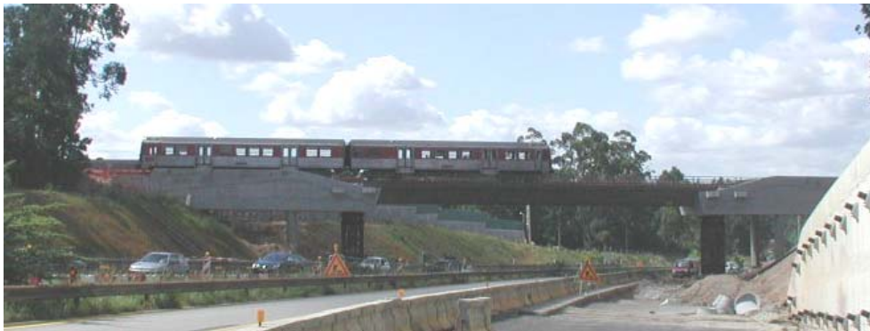
Figura 8: Vista geral da obra durante a operação de corte dos pilares
