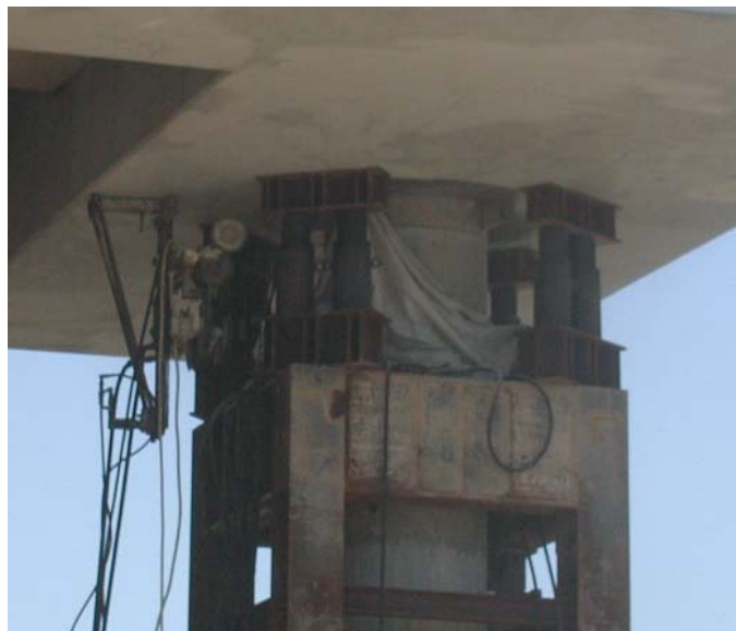
Figura 9: Equipamento de elevação do tabuleiro e dispositivo de corte com fio diamantado
